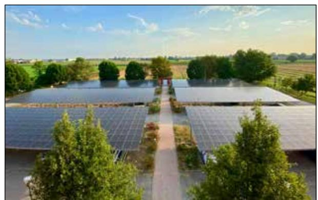
La realizzazione dell'impianto fotovoltaico ha comportato un investimento di oltre 1 milione di euro, con la previsione di un payback period di 9 anni. Il progetto di decarbonizzazione della sede centrale ha comportato anche la sostituzione delle caldaie a gas metano con l'installazione di pompe di calore elettriche bivalenti e prevede la sostituzione della totalità dei punti luce con lampade led a basse emissioni.
