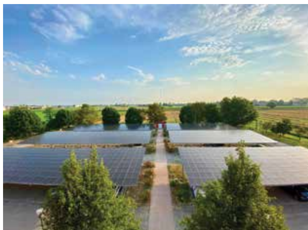
Il parco fotovoltaico a copertura dei parcheggi della sede centrale di Reggio Emilia
